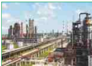
Bakı neftayırma zavodu
