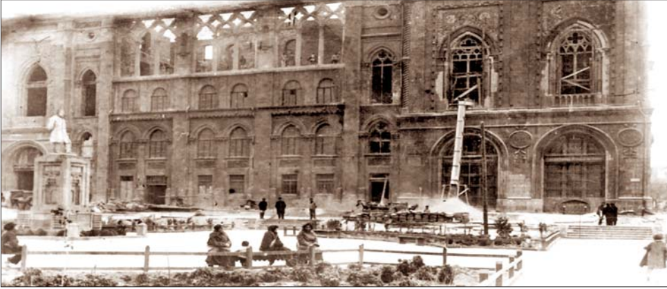
Müsəlman xeyriyyə cəmiyyəti binasının — «İsmailiyyə»nin (Hazırda AMEA-nın Rəyasət heyətinin binası) Mart soyqırımından sonrakı görünüşü
