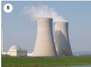
Elektrik stansiyalarının inşası
