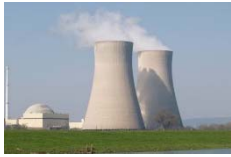
Elektrik stansiyalarının inşası
