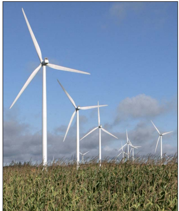
Külək elektrik stansiyası
