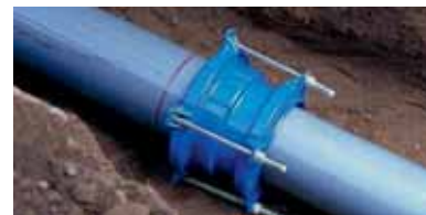
Компенсаторы позволяют трубам расширяться без повреждений.
