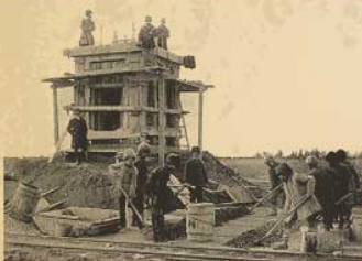
Строительство Шолларского водопровода
